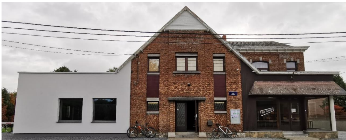
La salle des Thuyas vue depuis la rue avec à gauche la partie rénovée.
