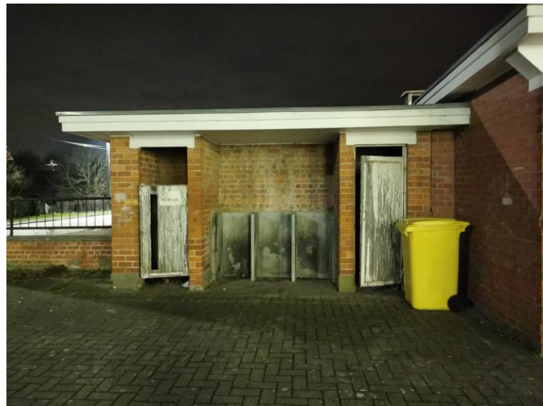
Bloc sanitaire à gauche du local des pionniers
