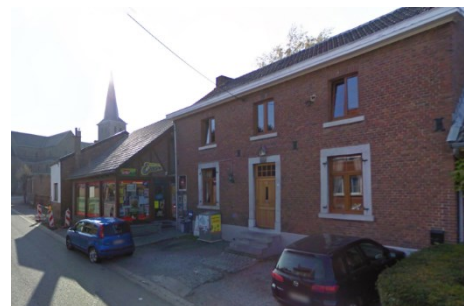
Photo 9 :- rue de l'Église, Verlaine Source : Streetview
